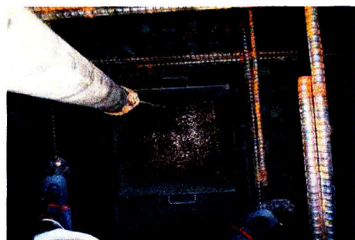
写真-4 鋼桁下面ホッパー内の充填状況
